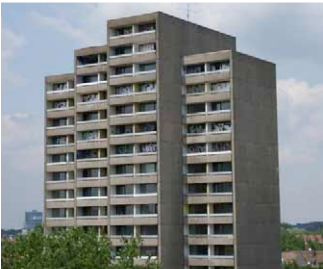
Das leerstehende Hochhaus an der Kielstraße
